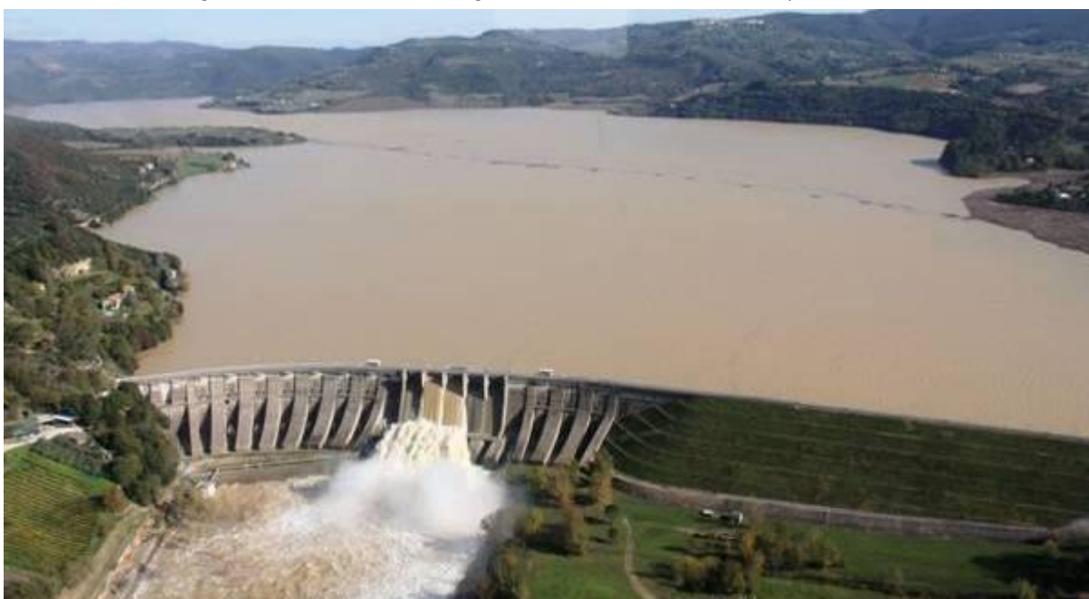
Fig. 4.1 Rilasci controllati della diga di Corbara, F. Tevere, durante la piena di novembre 2012
