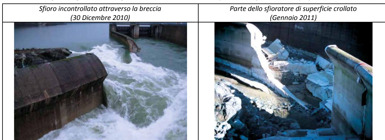
Fig. 4.6 Diga di Montedoglio sul Fiume Tevere. Rottura di parte dello sfioratore di superficie (Dicembre 2010)
