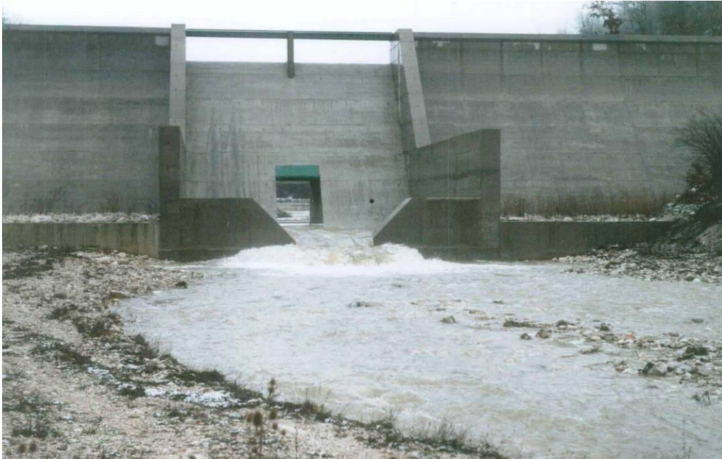
Fig. 4.5 Traversa di laminazione delle piene sul T. Corno in zona Ruscio di Monteleone di Spoleto
